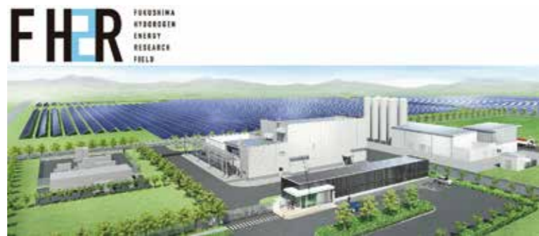
2020年度に実証運用が予定されている福島水素エネルギー研究フィールドの完成予想図。水素を「造り」「貯め・運び」「使う」という、未来の水素社会実現に向けたモデルの構築に取り組む
